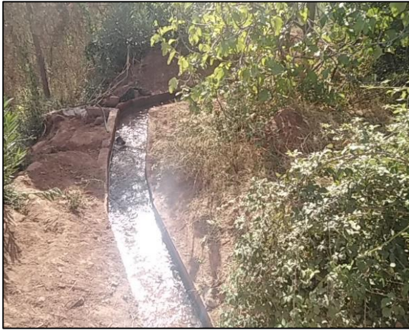
Figure 2-8: Seguia en béton en fonction
