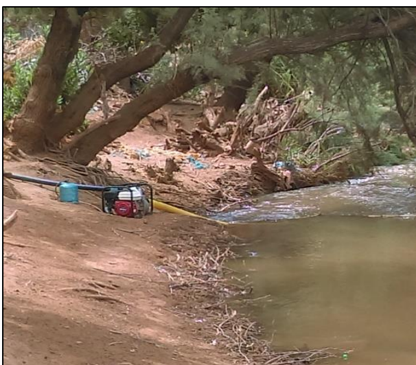
Figure 2-10 : Pompage direct de l'oued de Chbouka
