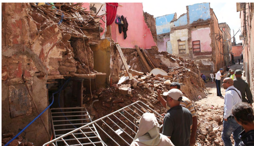
Figure 62 : Effondrement de plusieurs maisons traditionnelles à Derb Saba au quartier Al Mallah, 2013. (Akhmisse, 2013) 199
