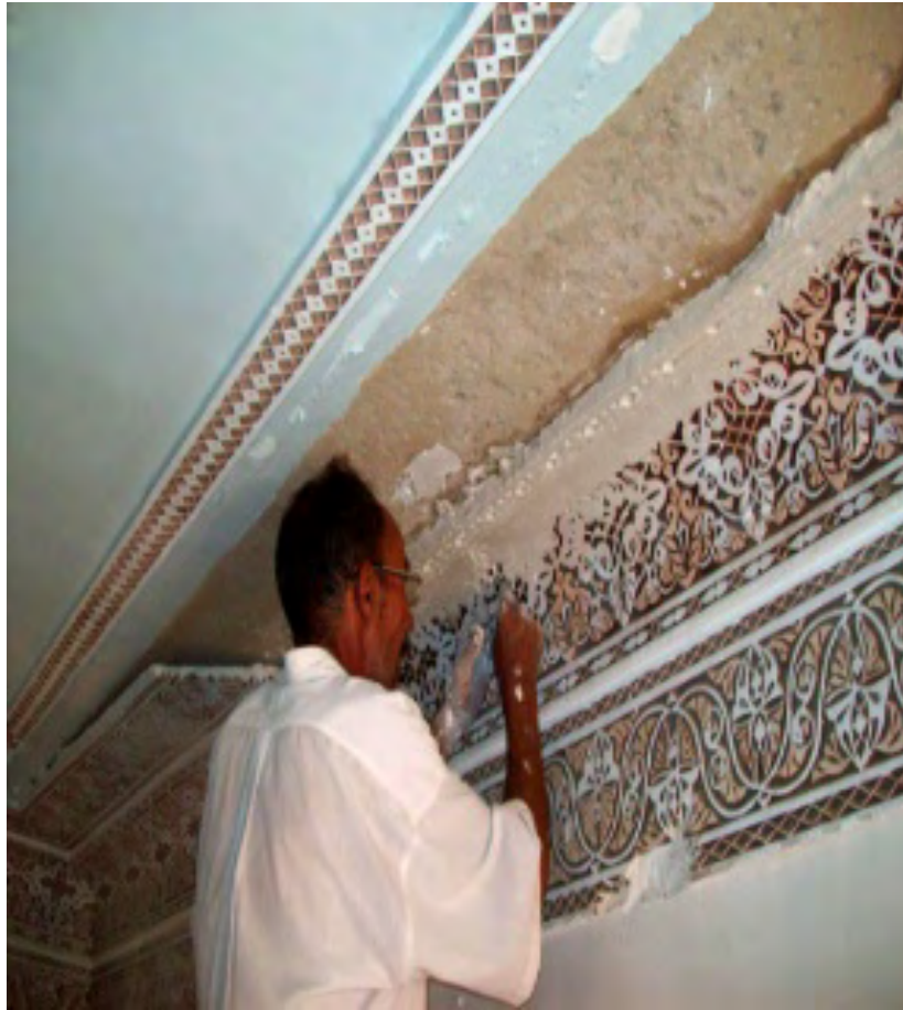
Figure 22 : Rénovation d'un toit en plâtre peint. Benaddi, 2017
