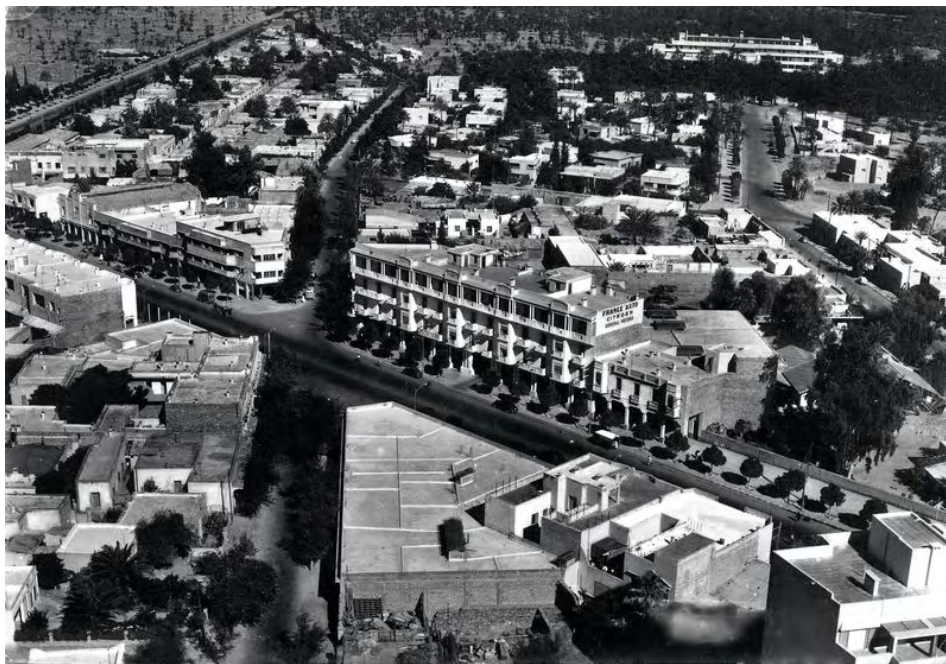
Figure 28 : La ville nouvelle du Guéliz- vue aérienne, 1940, Moulin.
