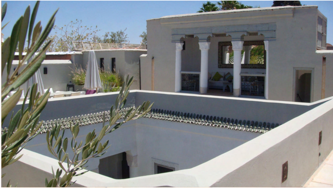
Figure 81 : une masrya réaménagée en espace de bien-être, Riad Idoine, Médina.
