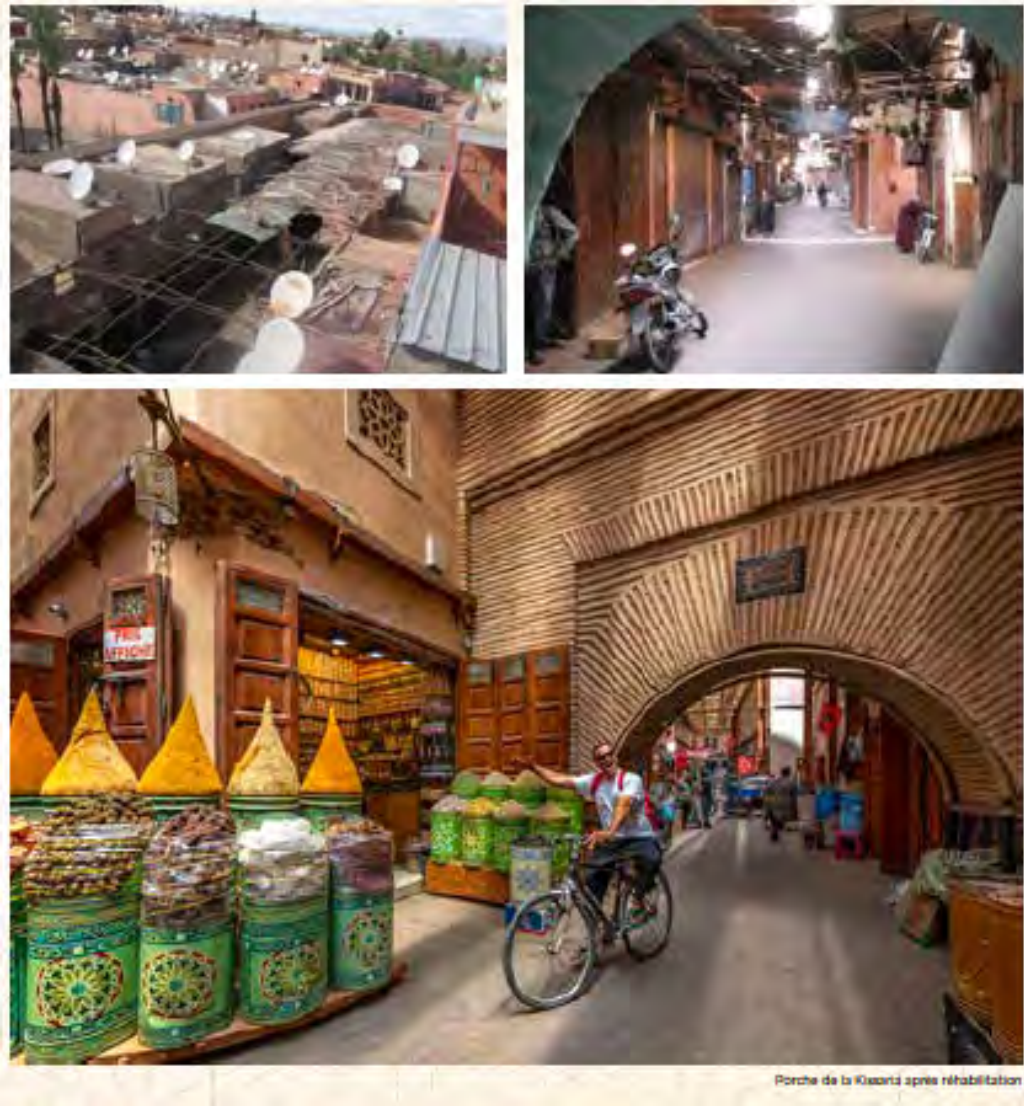
Figure 47 : Porche de la Kissaria du Mellah avant et après sa réhabilitation dans le cadre du projet « Marrakech, Cité du Renouveau Permanent », 2016
