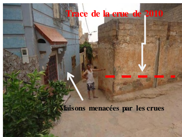
Maisons menacées par les crues des Chaabats Ain Elkhier Est et Ouest dans le quartier Elkhier (El Ksiba)
