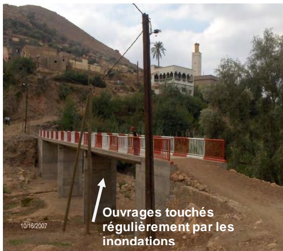
Influence des inondations sur le pont reliant les douars Takhamist et Taghzirt sur l'Oued Derna.
