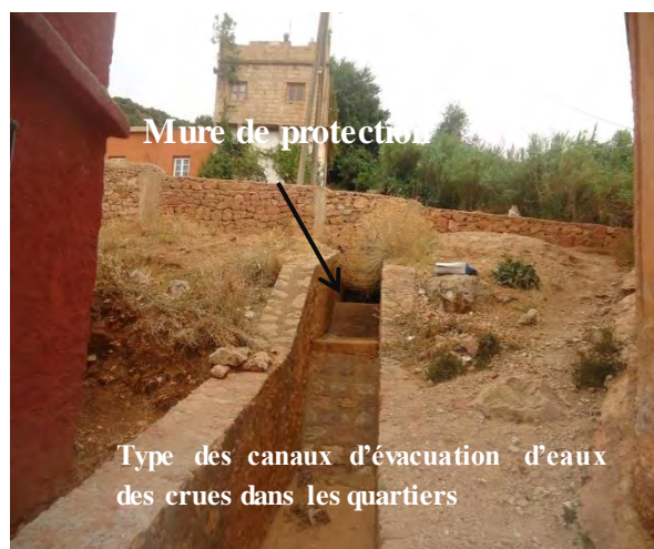
Type d'aménagements exécutés pour la protection de la ville d'El Ksiba et ces quartiers contre les Inondations de chaabats Aine elkhier
