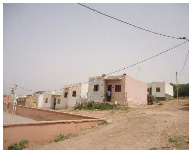
Les 16 maisons construites et le terrain de sport
