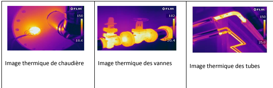
Figure IV. 3 : Diagnostic de l'installation thermique par thermographie infrarouge.
