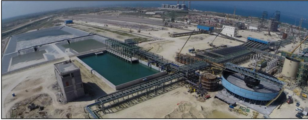
Figure 3. Station tête de traitement du phosphate à Khouribga
