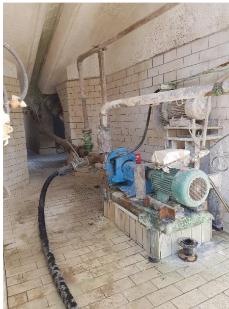
Figure. Décanteur des boues (gauche), Pompe centrifugeuse d'extraction des boues (droite)
