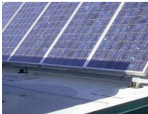
Figure 4.2: Exemple d’ombre causant la perte de la majorité de la production
