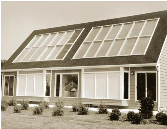
Figure 6 : Première maison alimentée par cellule PV
