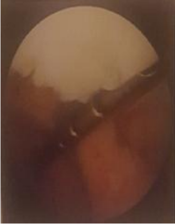
Figure32 : grosse fissuration en gueule de requin
