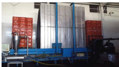
Figure 3: Passage des palettes au Drencher
