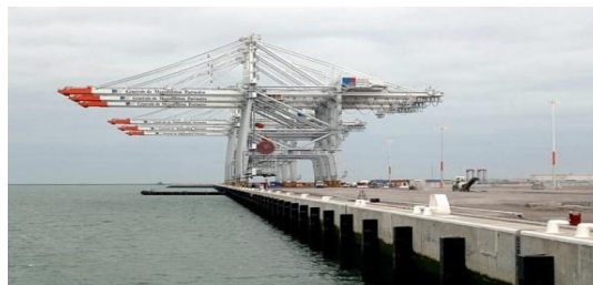
Figure I-10. Grues de quai
