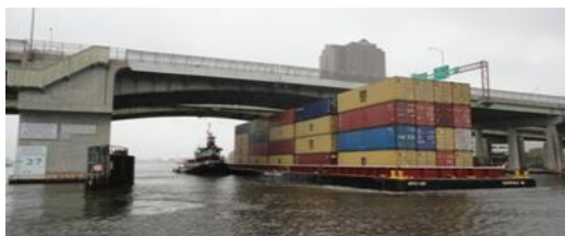
Figure I-4. Passage d'une barge sous un pont
